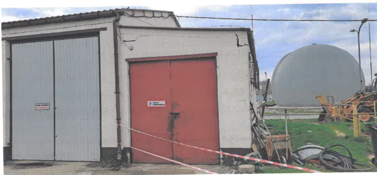
Rysunek 1. Budynek przeznaczony do rozbiórki. Widok od strony południowej.
